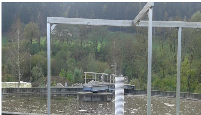
Slika 6: Usedalni bazen s prisotnimi mikroorganizmi, ki se uporablja za sekundarno čiščenje.
